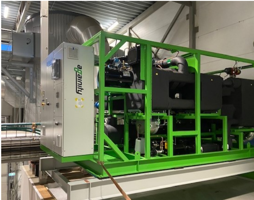
Againtys 0,5 MW ORC-system av samma modell som installeras i Finspång under hösten.
