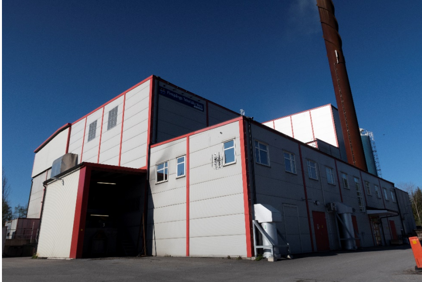
Värmeverket, Finspångs Tekniska.
